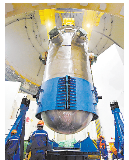
右图：福清核电5号机组反应堆压力容器抱环拆解现场。
