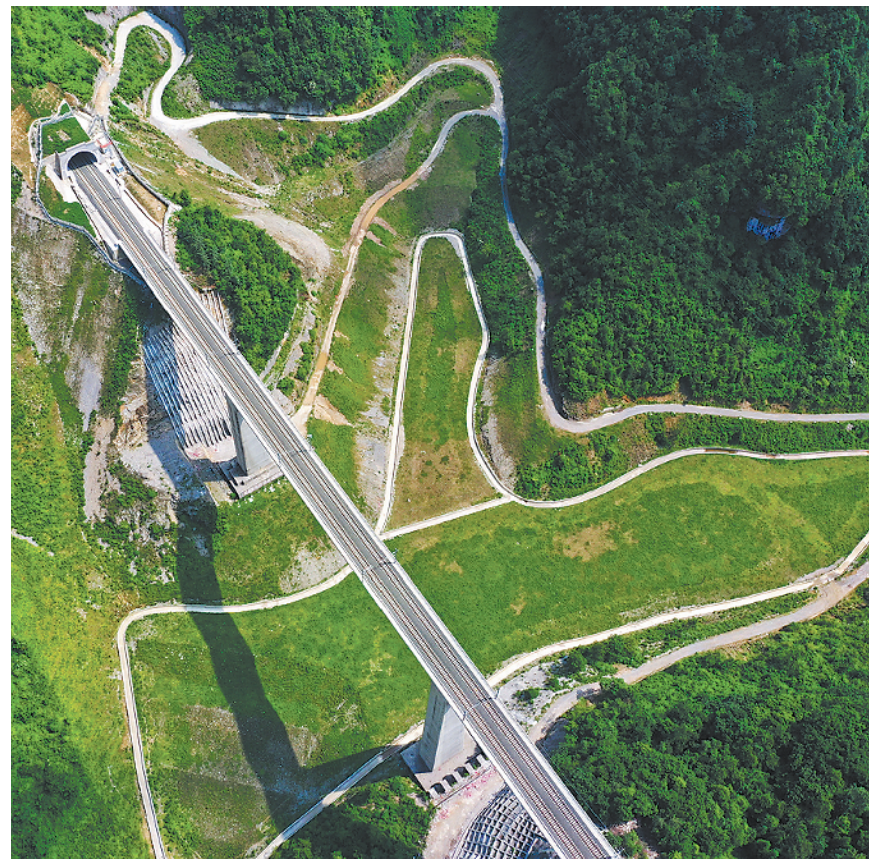
7月6日,新建贵州安六铁路(安顺至六盘水)联调联试工作进入收尾阶段,开通前的各项准备工作已基本就绪。建成投用后,贵阳至六盘水的铁路旅行时间可从现在的3.5小时缩短为1小时左右。图为无人机拍摄的安六铁路彭家冲一号大桥。 新华社发
