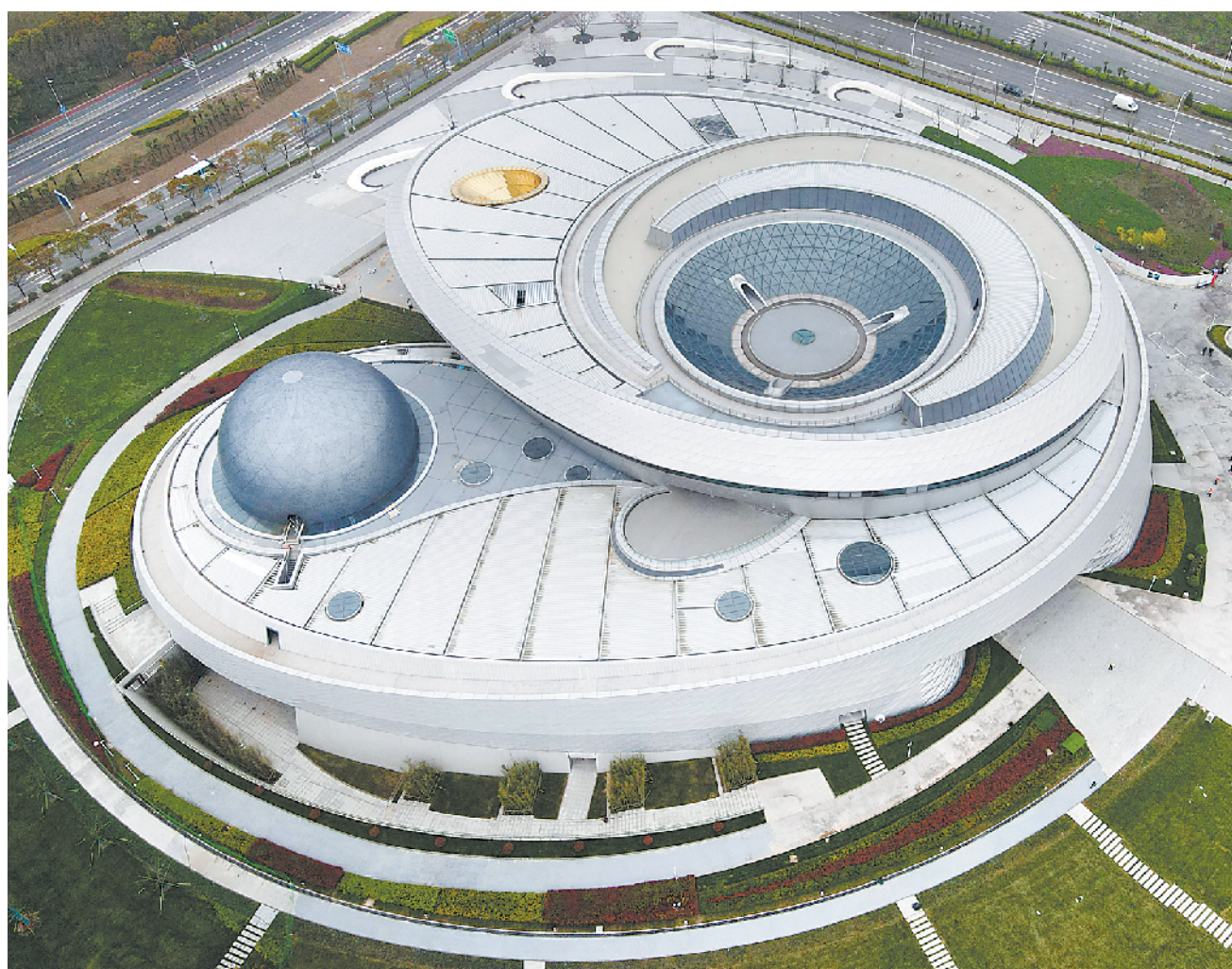
位于上海浦东新区的上海天文馆项目已临近整体工程尾声，除主体建筑外，场馆配套建筑设施建设也正有条不紊地推进。上海天文馆建筑面积超38000平方米，包括一幢主体建筑，以及青少年观测基地、大众天文台和魔力太阳塔等附属建筑。
