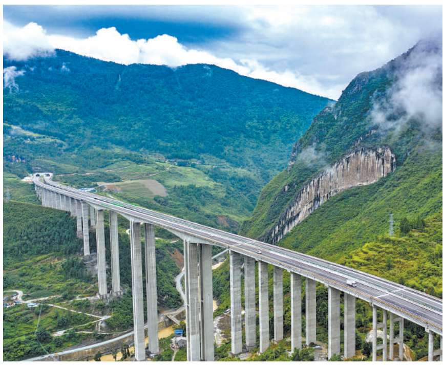
7月1日,贵州省遵义市正(安)习(水)高速公路全线通车。正习高速公路横穿乌蒙山区域,途经正安、桐梓、习水3县,全长约130公里。图为车辆行驶在正习高速道角大桥上。新华社发
