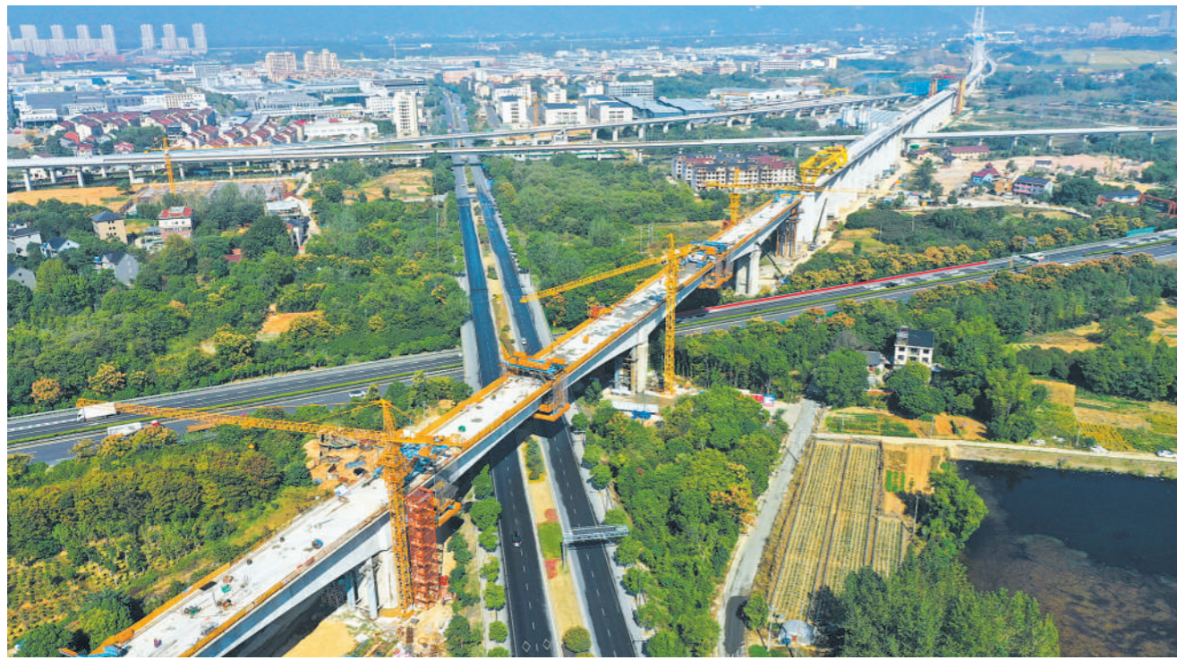
10月20日,位于浙江杭州桐庐县境内的杭温铁路二期工程跨杭黄铁路特大桥长达390米的连续梁顺利合龙。
